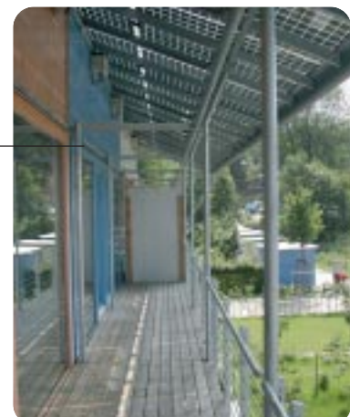
Abbildung 6 Horizontale Abschattungsflächen mit integrierten Solarzellen (Solarhäuser in Freiburg (D))
