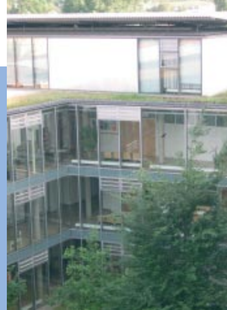
Abbildung 2 Bürotrakt der Handelskammer in Freiburg (D); gutes Beispiel für die Umsetzung von Maßnahmen zur Reduzierung der Kühllast im Sommer (Sonnenschutz und Belüftung des Daches), Abschattungsvorrichtungen und begrüntes Dach
