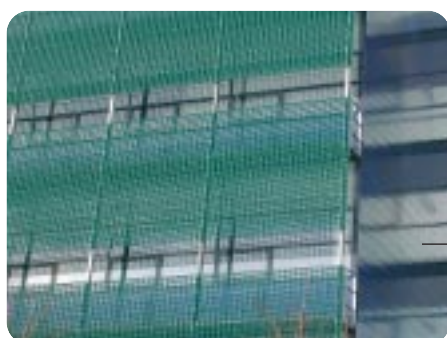
Abbildung 4 Vertikale Abschattungselemente in einem Bürogebäude in Dresden (D)
