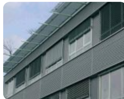
Abbildung 5 Sonnenschutz durch horizontale Abschattungsflächen und Außenjalousien in einem Bürogebäude in Dresden (D)
