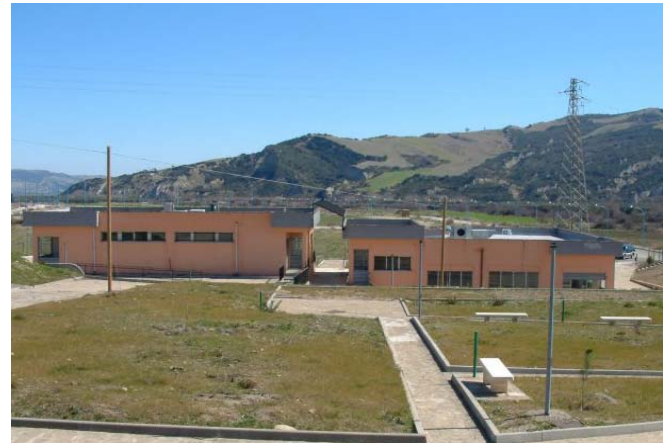
Fig. 1 The Centro Eccellenza Bioenergia
