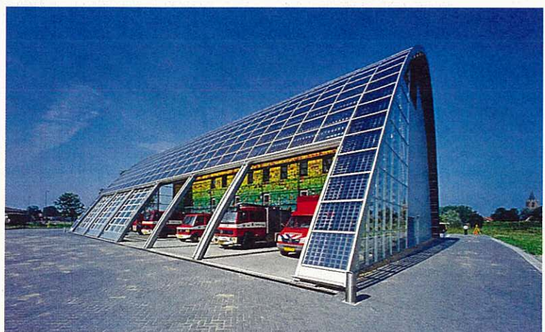
Abbildung 1: Feuerwehrrhaus mit Photovoltaikfassade in Houten
