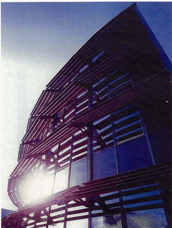
Abbildung 4: Wirtschaftshof Linz mit sonnenstands-nachgeführten Photovoltaik-Beschattungselementen
