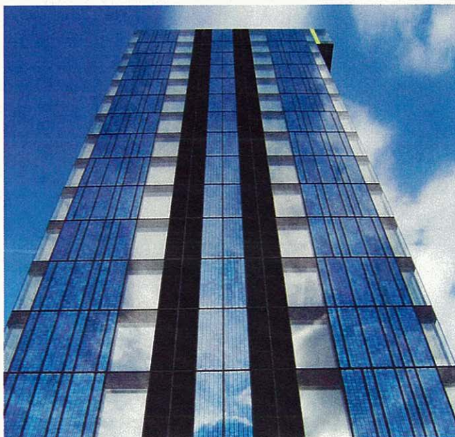
Abbildung 5: Power Tower Linz mit fassadenintegrierter PV-Anlage
